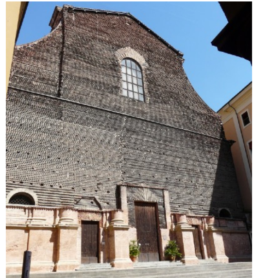
Placage en marbre inachevé sur un mur pignon construit en moellons - Bologne - XVIIème siècle
