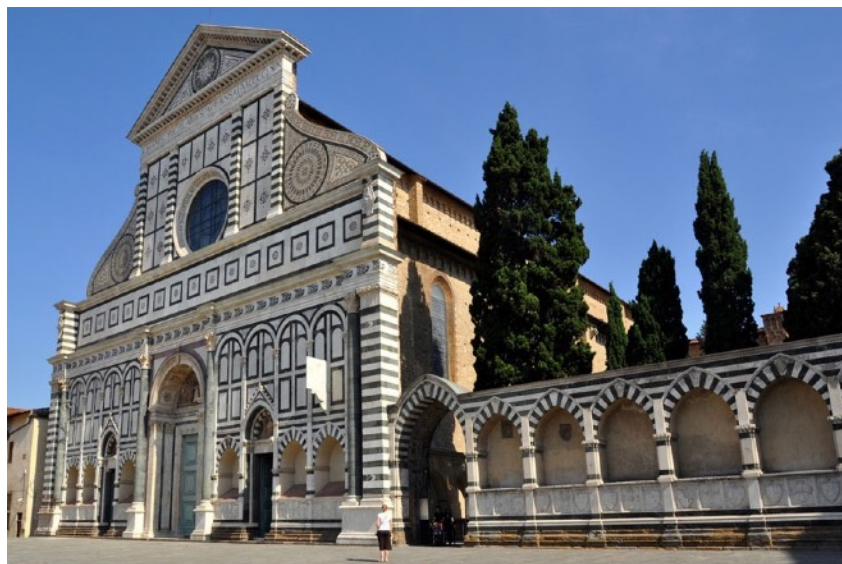
À Santa Maria Novella, les ailerons cachent la toiture, rompent la sécheresse des angles droits et amènent, en douceur, le regard vers l'étage supérieur et le fronton.
